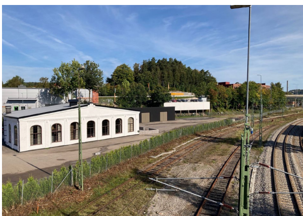
Lokstallet byggdes ursprungligen för Borås-Ulricehamns Järnväg år 1917. Den välbevarade byggnaden är idag kontor i ett brokigt industriområde utmed riksväg 40.
