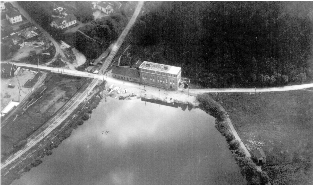
Historisk flygbild som visar Bockasjön och transformatorstationen byggd 1907-1926. Byggnaden används idag som kontor.
