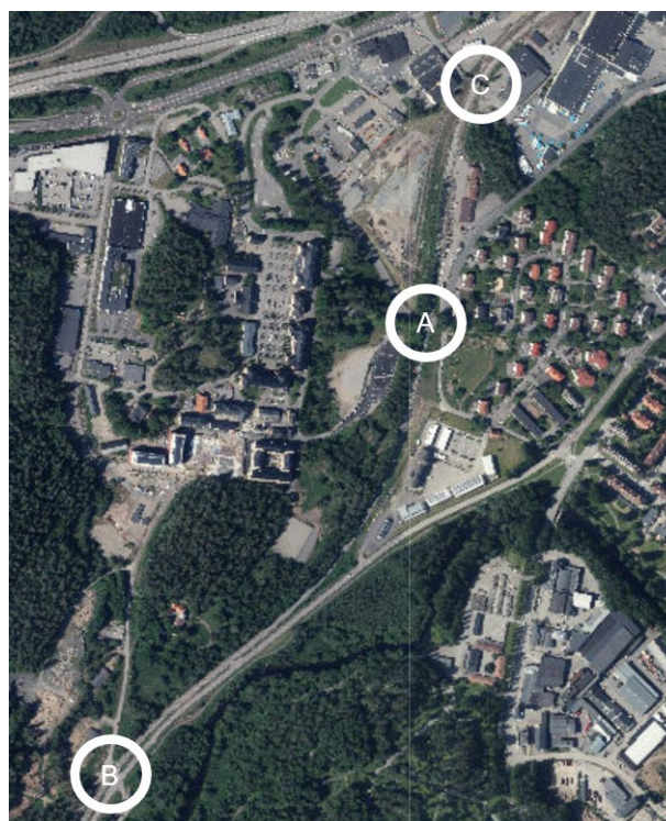
I området finns i tre passager över järnvägen. De två sydligaste (A, B) kommer behöva ersättas med planskilda lösningar. Norra gångbron (C) behöver troligen ersättas på grund av att spårområdet förändras.
