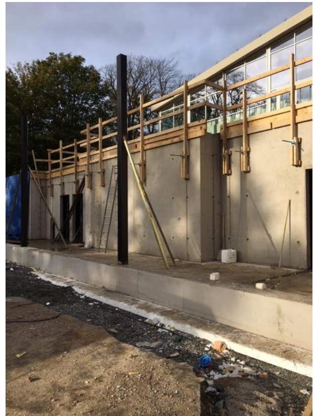
Nygjutna väggar mot nya omklädningsrum
