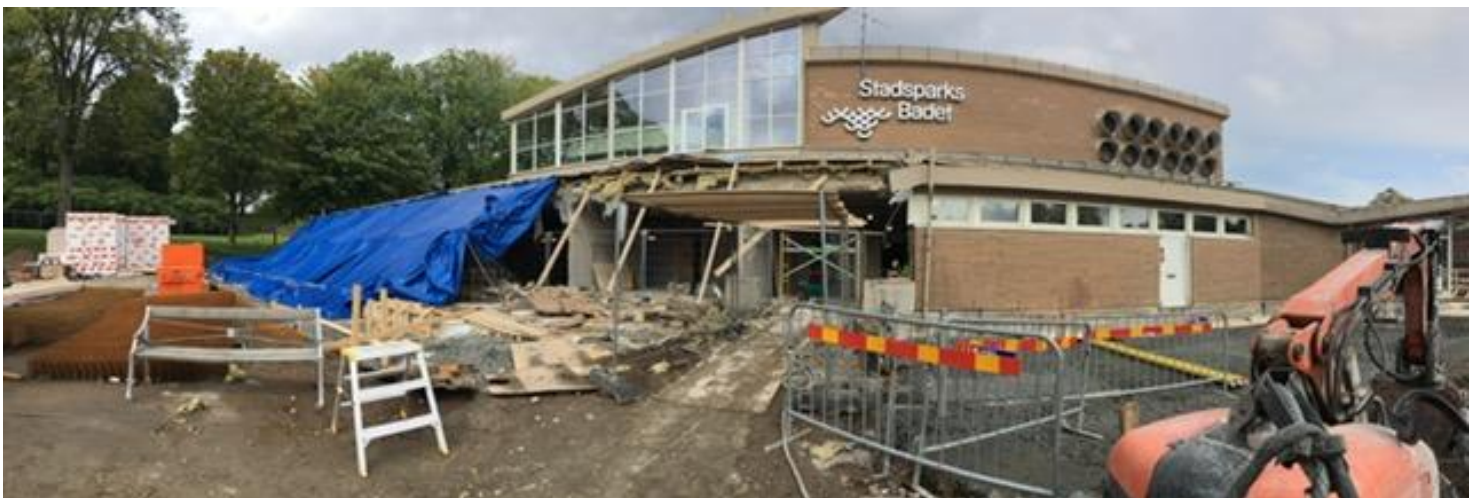
Under rivning av fasad
