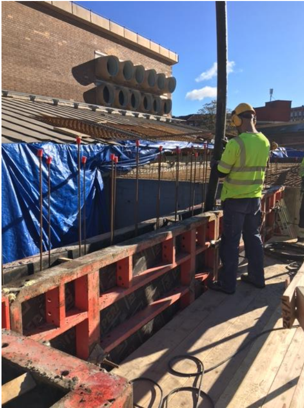
Gjutning i väggform
