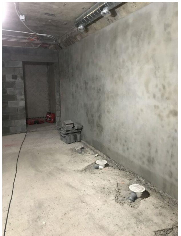
Nyputsade ytor i duschrum
