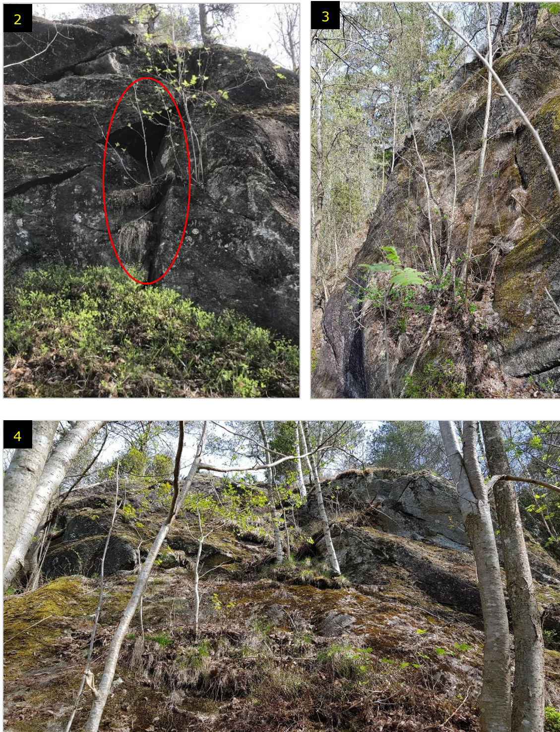
Figur 7. Lokal 2 består av en brant bergsslänt med spår av tidigare blockutfall inringat i rött i bild 2. Bild 3 visar släntens lutning, och bild 4 visar slänten sett nerifrån.
