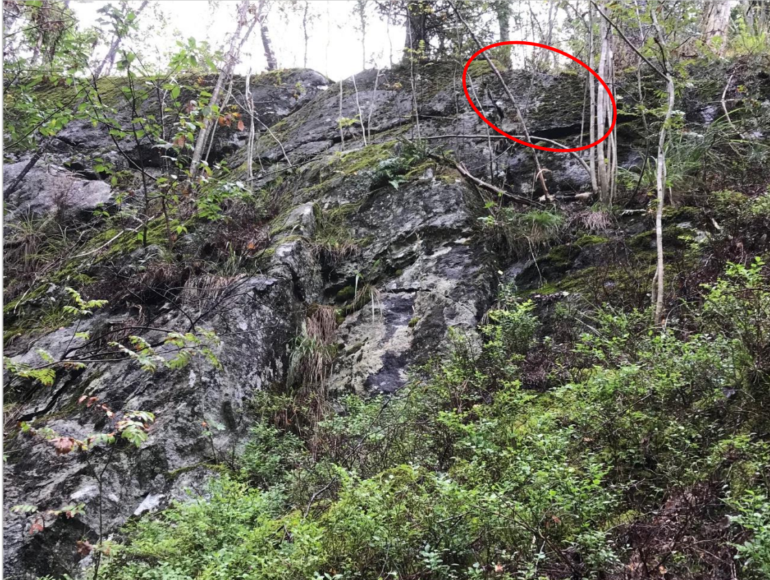
Figur 11. Löst block som riskerar att falla ner ur berget på grund av ogynnsamma sprickriktningar.
