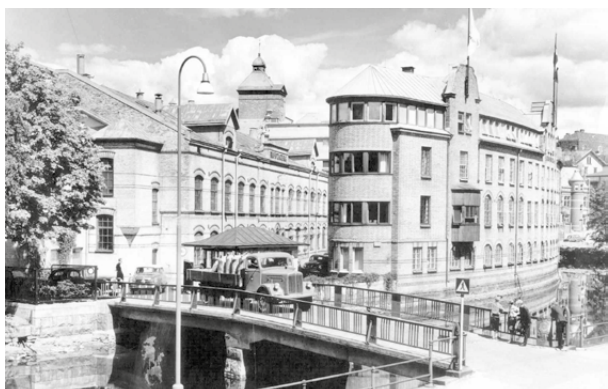
Borås Wäveris karaktäristiska rundade kontorsbyggnad är uppförd under tidigt 1900-tal, med fyra/fem våningar och gult tegel. Bild från 1950-tal.
