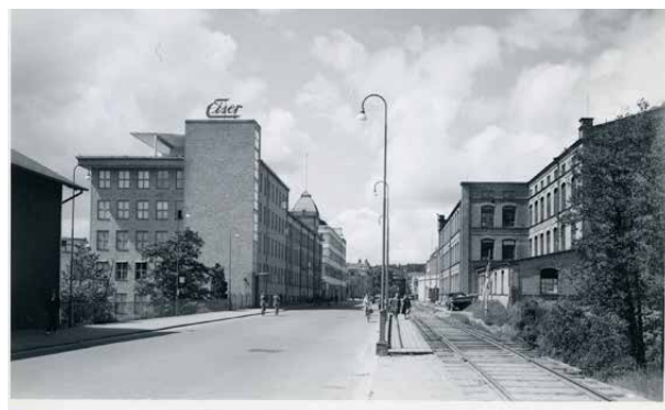
Spårvägen genom Eisers fabriksområde (idag Pulsenområdet) innan väg 40 byggdes.
