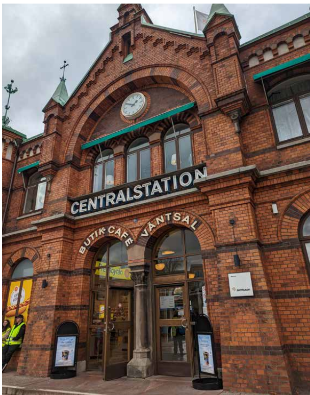
Stationshuset uppfördes av 1894 av Göteborg-Borås Järnvägsaktiebolag och tillbyggdes 1904 till nuvarande volym. Den ansluter stilmässigt i nyromansk stil med torn och runda fönsteröppningar och är skyddad som statligt byggnadsminne.
