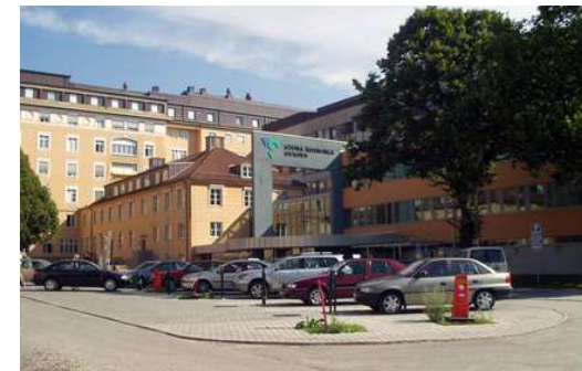
Södra Älvsborgs Sjukhus (Bildkälla: Västfastigheter)
