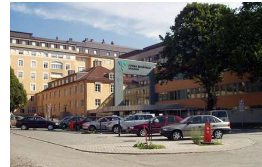
Södra Älvsborgs Sjukhus (Bildkälla: Västfastigheter)
