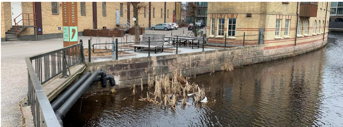
Bild 1: Muren norr om Viskaholmsbron
