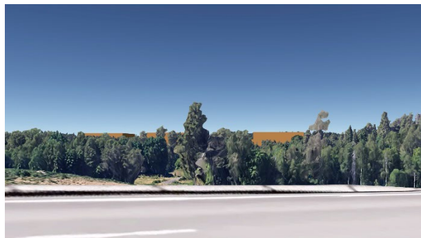
Figur 7 Samma vy som till vänster, men med volymen på 35 meter uppdelad i flera mindre byggnadsdelar.
