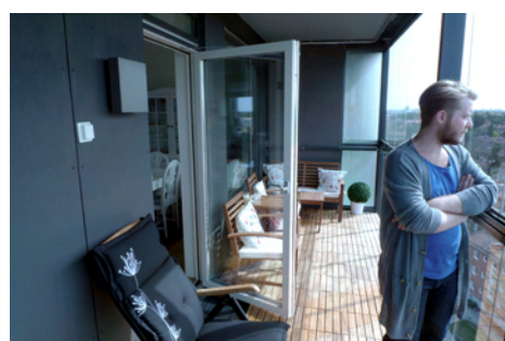
Fig. 6a, b: Loggiorna har generösa möbleringsmått och skyddas av öppningsbara glasluckor. Referensbild från Brommahöjden, Stockholm, arkitekter: Joliark.
