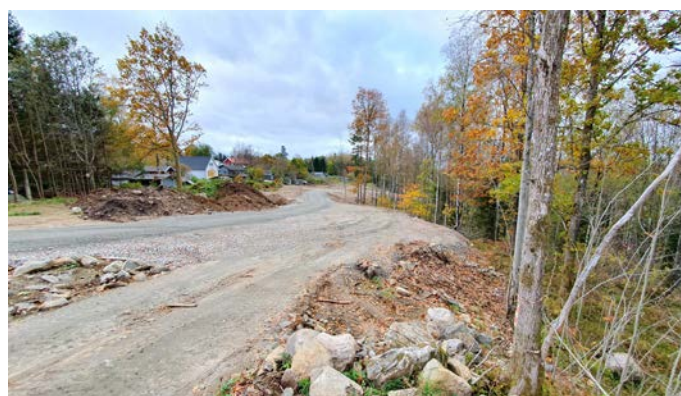
Ny lokalgata (VA-arbetsvägen), foto uppför bakom Norra Klampevägen
