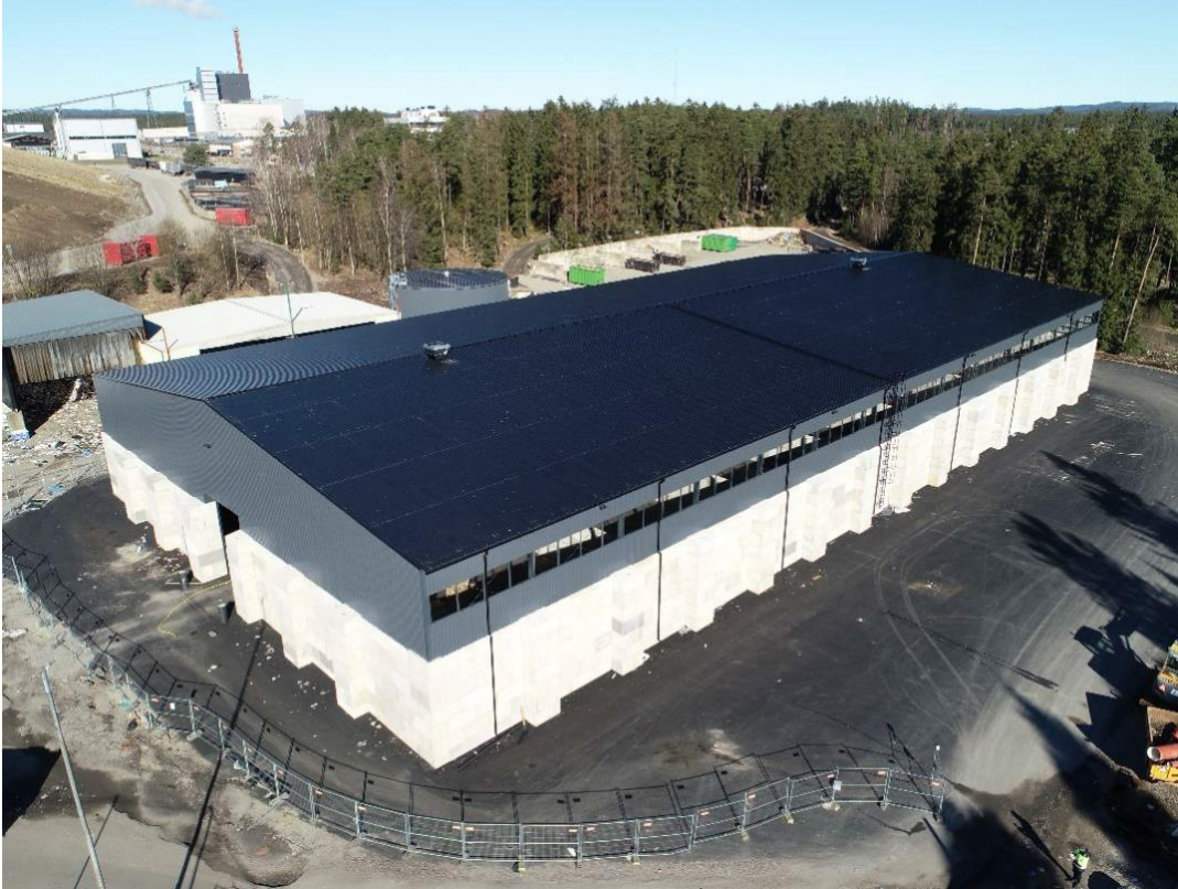
Figur 3: Bild på den nya materialhallen för mellanlagring av avfall
