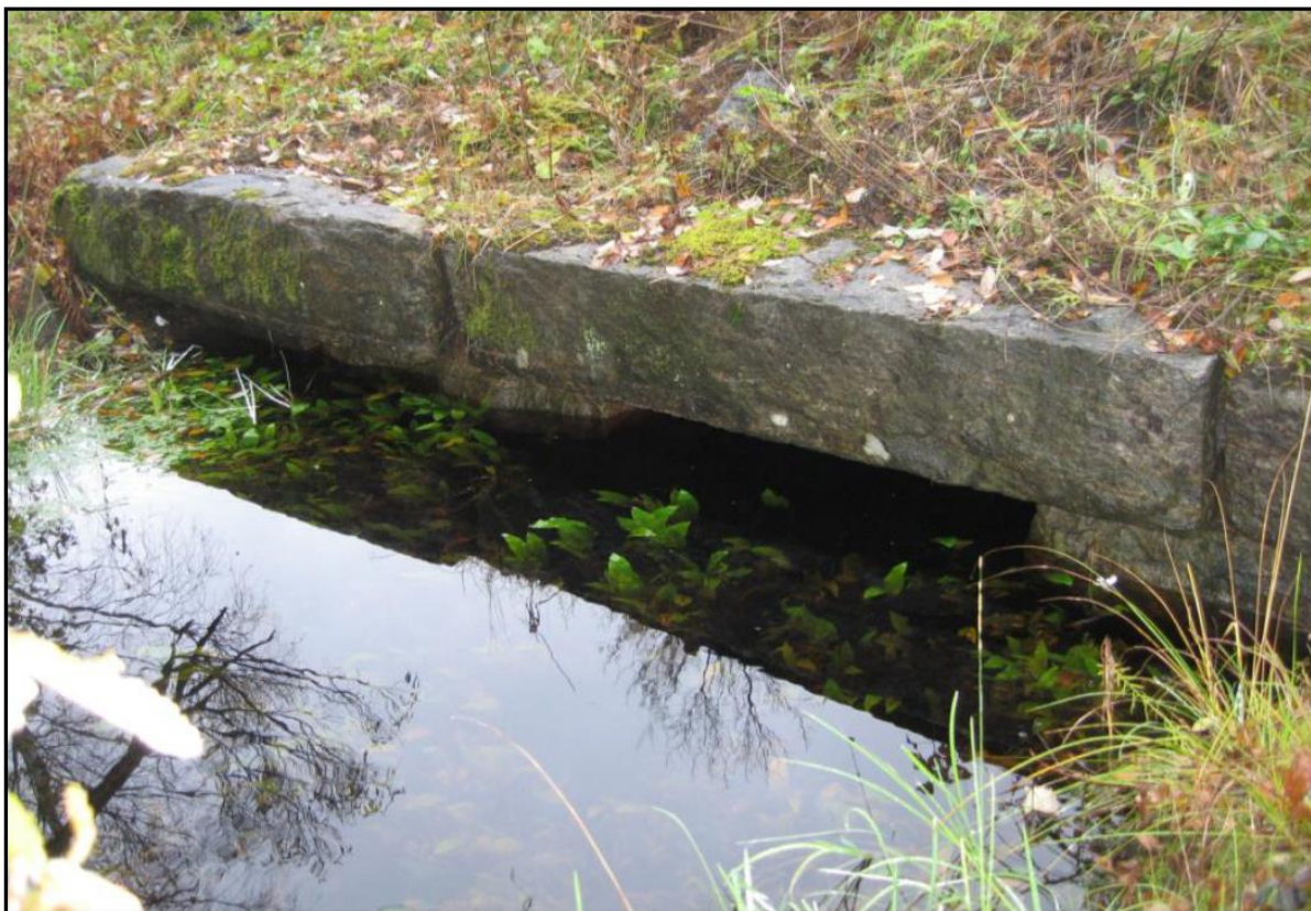
Figur 7. Stenkulvert under Segloravägen.
