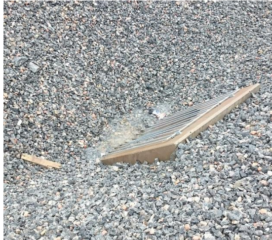
Figur 4 Västra delen av ovan nämnda kulvert. Den stående vattenytan i kulvertens underkant kan tyda på att kulverten utgör en dräneringsnivå.
