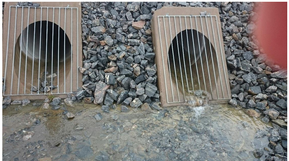
Figur 3 Kulvertar vid väg i öst. Vänstra kulverten kommer längre upp längs vägen (SV-V). Den högre går rakt under vägen till andra sidan (se figur 4).
