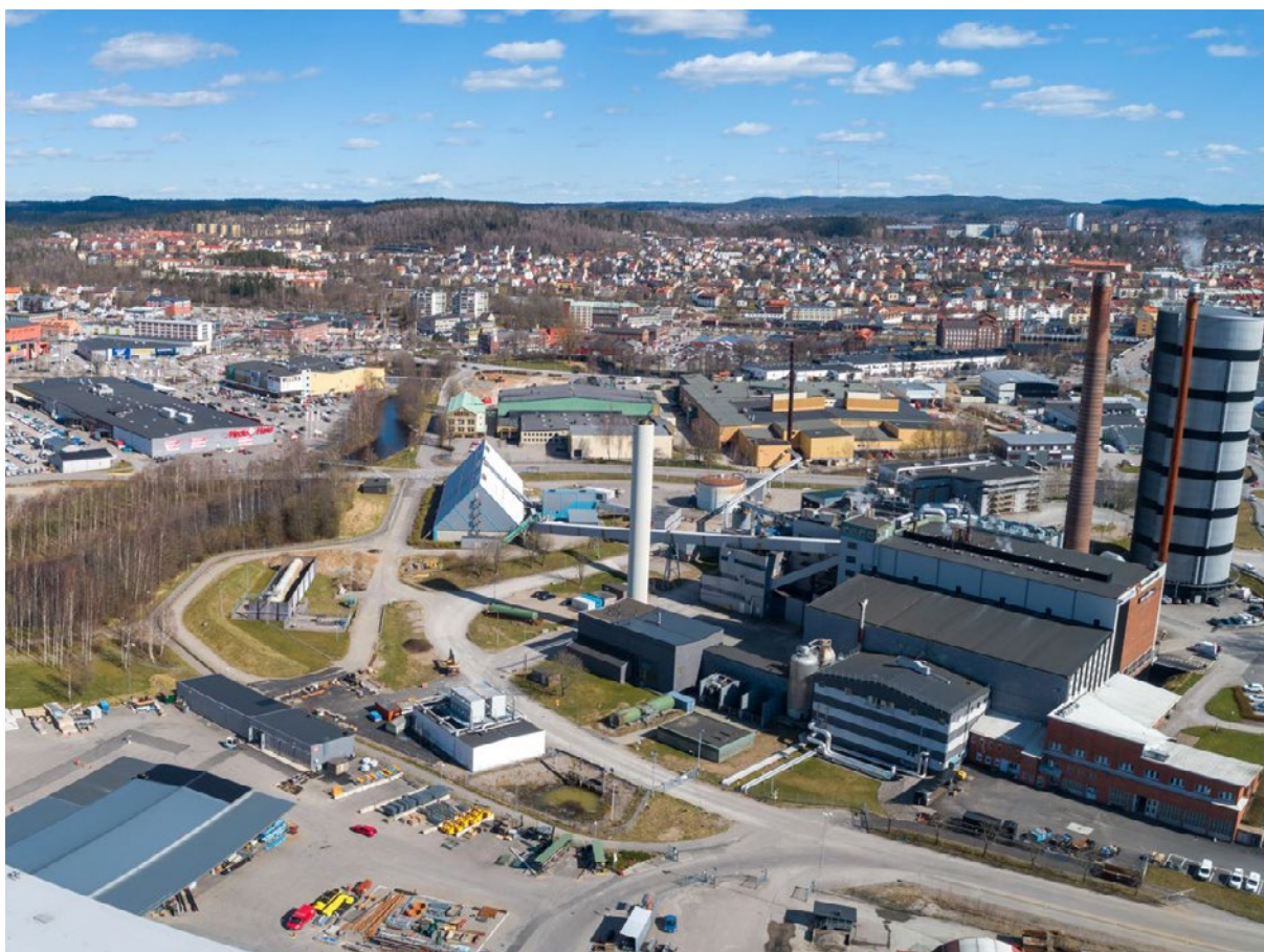
FOV fabrik i område A. Foto: Sweco
