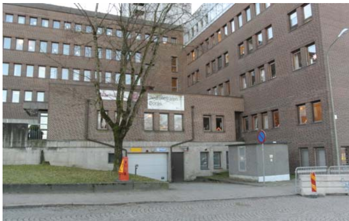
Entré till garaget och transformatorstationen vid Kvarngatan.
