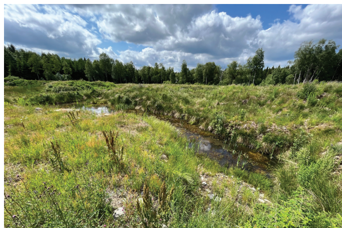
Befintlig damm avses utnyttjas som dagvattendamm.
