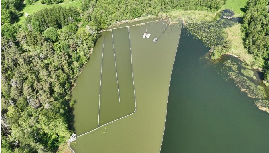
Figur 10 Siltgardiner som används vid muddring av sjön Flaten, Stockholms kommun.
