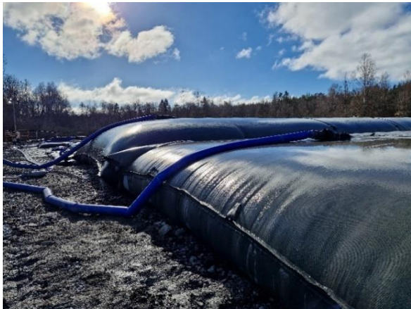
Geotuber, massorna avvattnas genom att vattnet tränger ut genom textilmaterial
