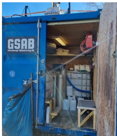
Blandningscontainer där flockningmedel tillsätts muddermassorna
