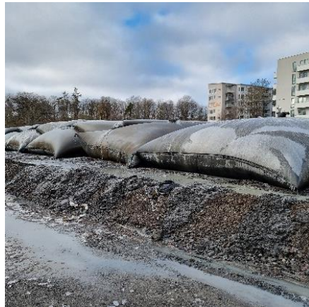
Vattnet som tränger ut kan samlas upp i en invallning och renas vid behov. I detta fall krävdes ingen rening för utsläpp tillbaka till det muddrade området.
