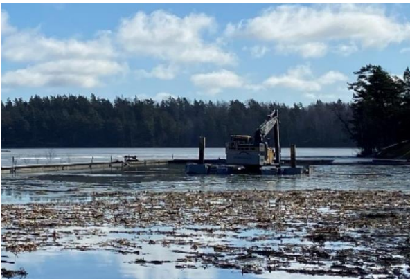
Sugmudderverk på pråm, massorna pumpas i 200-ledning
