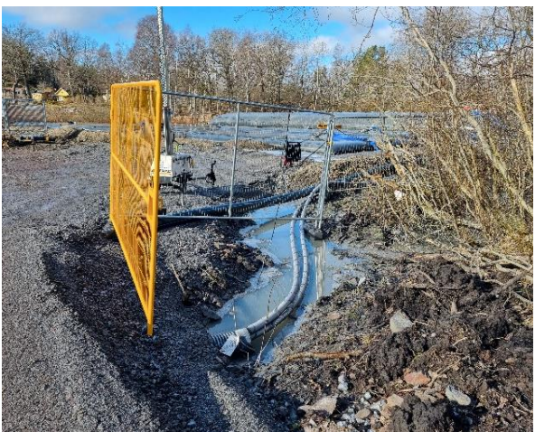
200-ledningen kan enkelt läggas i grus för att fordon ska kunna köra över utan att skada ledningen
