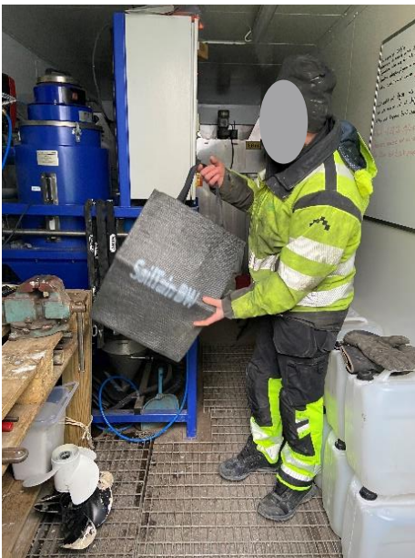
Figur 14. Container med flockningsmedel, avvattningspåsen (s k shoppingbag) används här för att kontrollera avvattningsgraden under själva muddringsprocessen.
