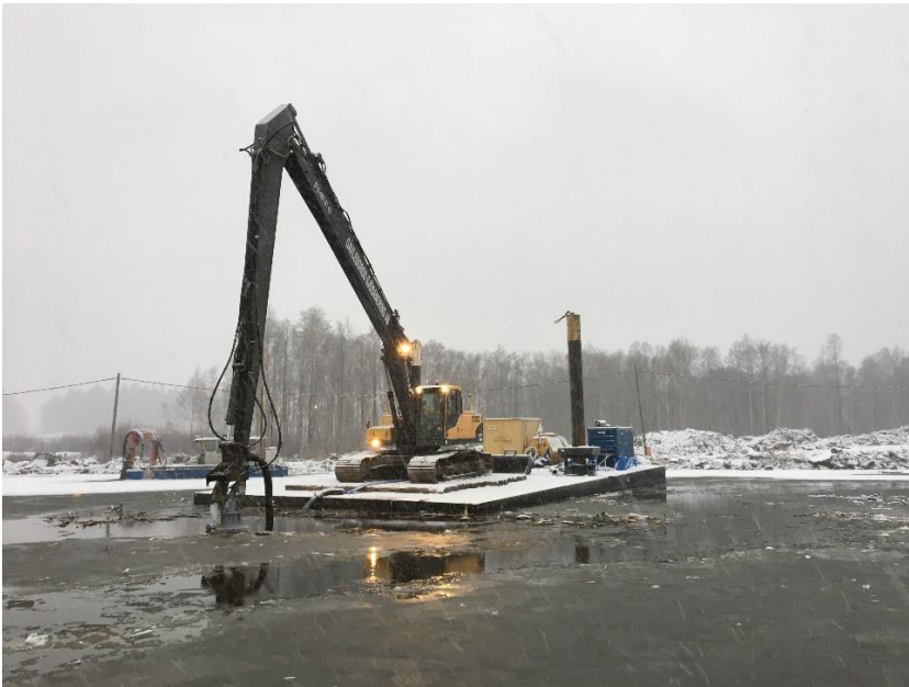
Figur 7. Sugmudderverk och sugmuddermunstycke
